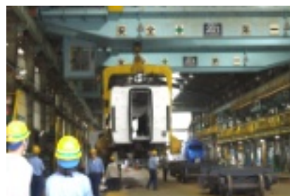
超大型クレーンで釣り上げて安全運行のための点検・整備
